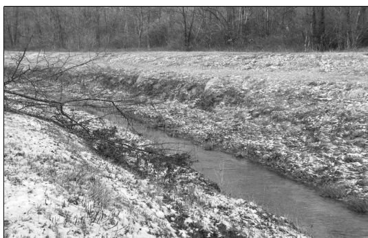
Slika 8. Prikaz primjene fotografiske metode za procjenu koeficijenta hrapavosti n na primjeru korita odvodnog kanala Butoniga (Stacionaža 05+700,00 km)
