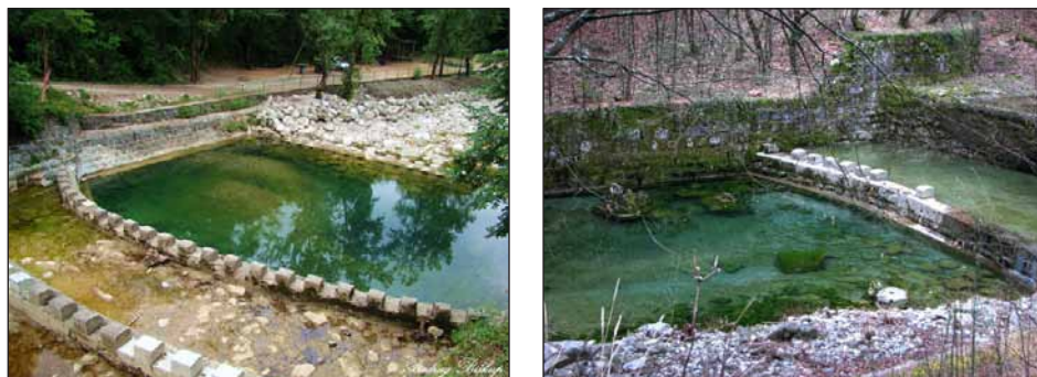
Slika 1. Energetski disipatori na Rječini (fotografije su snimljene u nepoznatom vremenskom odmaku te se može primijetiti da pojedini energetski disipatori nedostaju, što može biti posljedica dugogodišnjeg silovitog hidrodinamičkog djelovanja vode)
