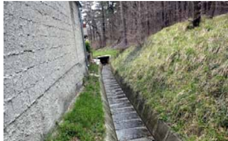
Prefabricirana kineta (3b) te propusti ispod kuće (pc2)
