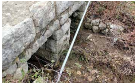
Cestovni propust (Pc5)
