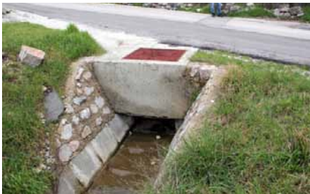
Cestovni propust (pc4)
