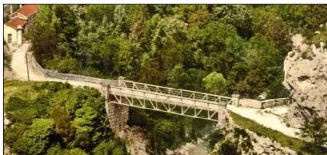
Slika 28. Željezni žakaljski most [3]
