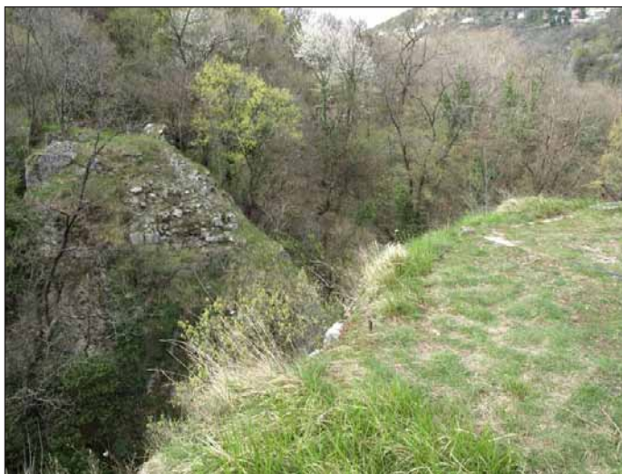
Slika 29. Ostaci upornjaka žakaljskog mosta [4]
