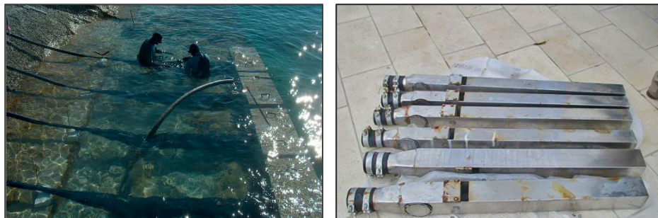
Slika 4. Dijelovi cijevnog sustava Morskih orgulja: lijevo, PE potopljene cijevi [1] i desno, inox akustične cijevi [2]
