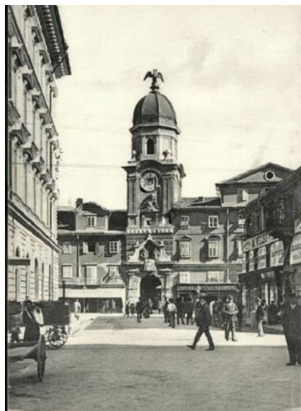
Slika 3. Izgled kupole nakon obnove [2]
