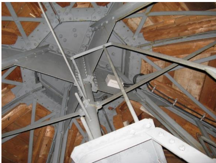
Slika 5. Rešetke spojene na središnji stup
