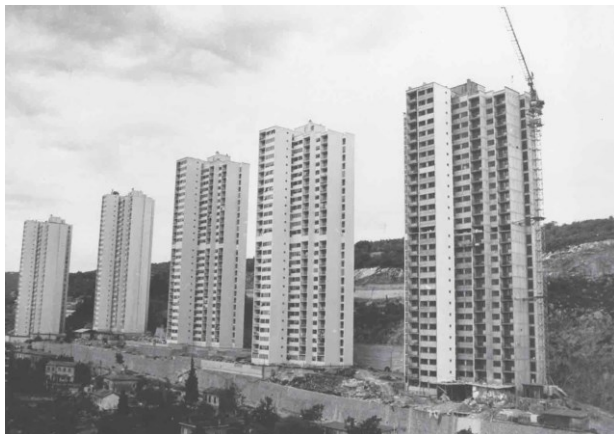
Slika 8. Fotografija naselja 'Eševa' u tijeku gradnje (arhiv Muzeja Grada Rijeke)
