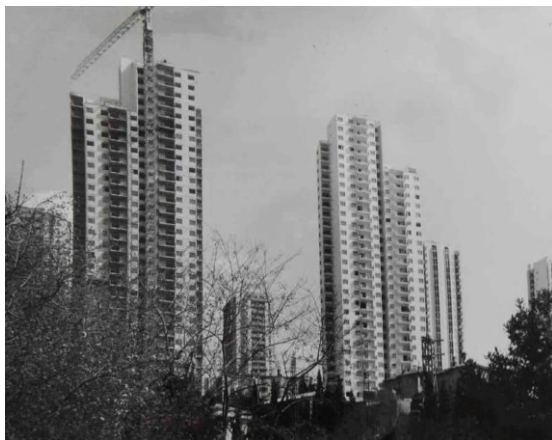
Slika 6. Fotografija nebodera u gradnji na Turniću (arhiv Muzeja Grada Rijeke)
