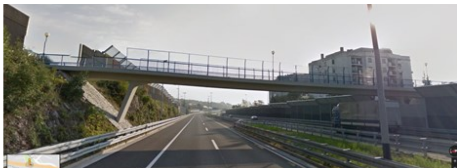
Slika 1. Pogled na most Malonji [3]
