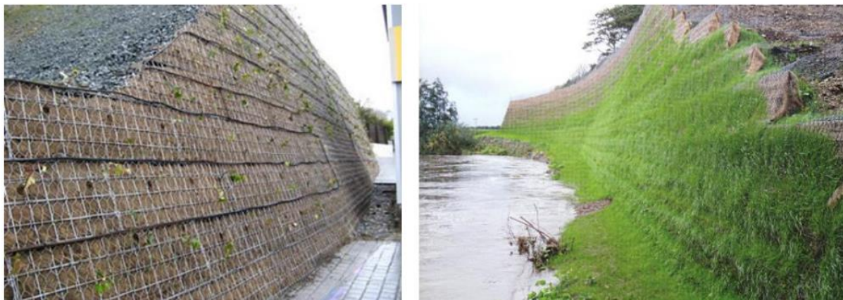
Slika 100. Prikaz uporabe GREEN TERRAMESH sustava
