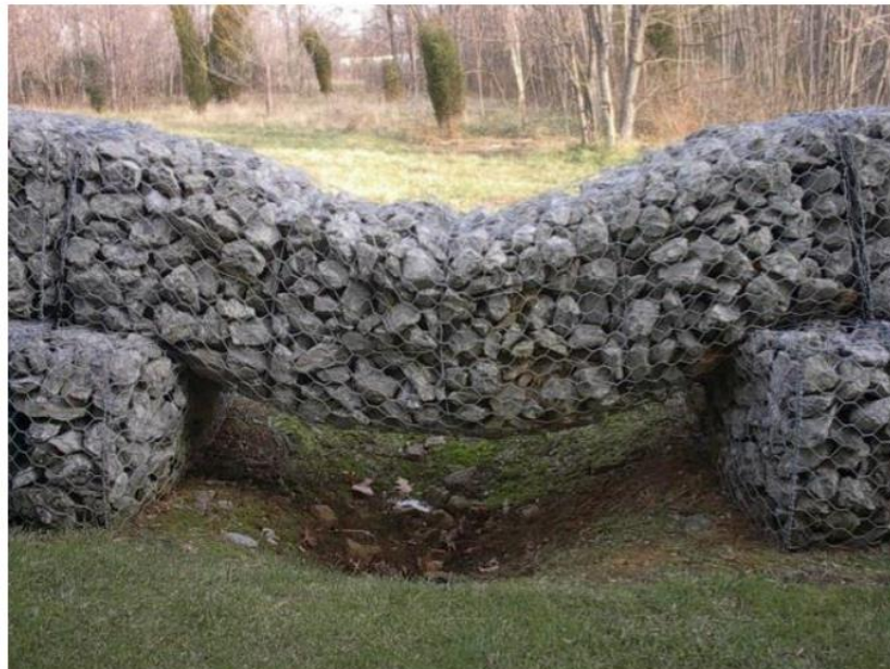
Slika 95. Primjer fleksibilne gabionske konstrukcije.
