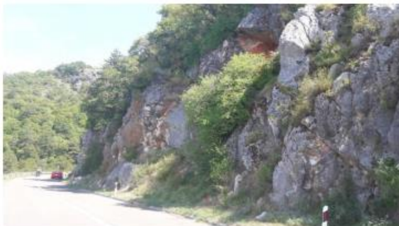
Slika 116. Predmetna kosina u sklopu inženjerskog bloka 2
