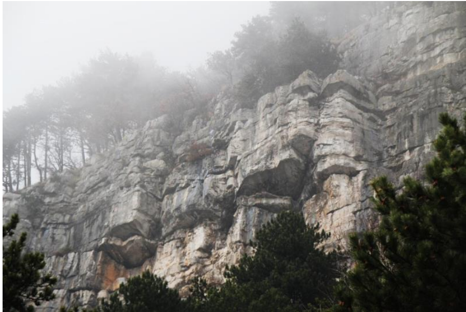
Slika 131. Segment B s vidljivim nestabilnim blokovima (Grošić 2012)
