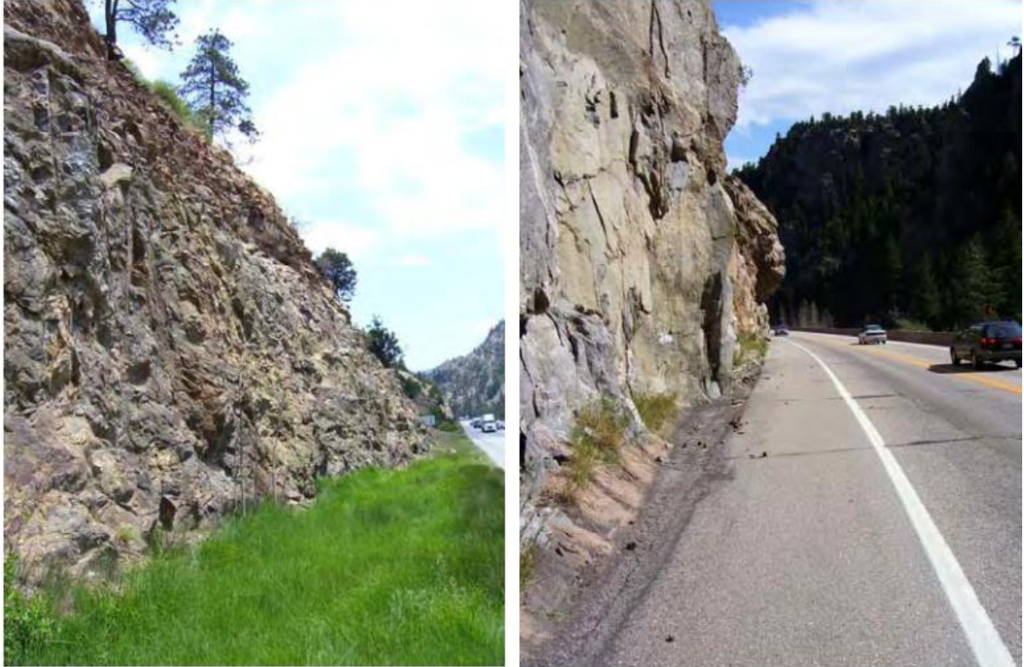
Slika 22. Primjeri različitih stupnjeva prevjesa u kristaličnoj stijenskoj masi
