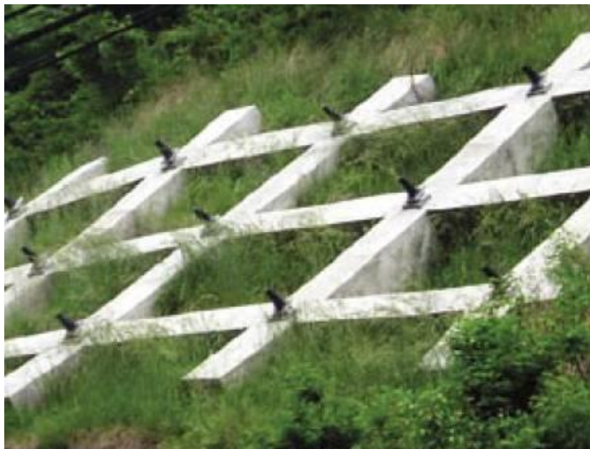
Slika 87. Potporna roštiljna konstrukcija u kombinaciji sa sidrima
