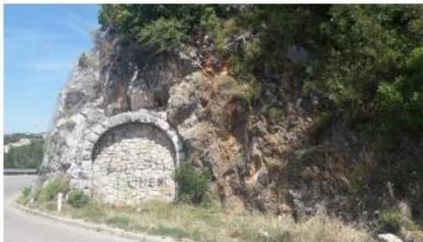
Slika 120. Predmetna kosina u sklopu inženjerskogeološkog bloka 6
