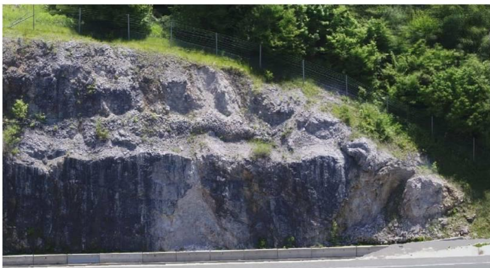
Slika 13. Primjer vlažnog pokosa ocijenjen s 9 bodova
