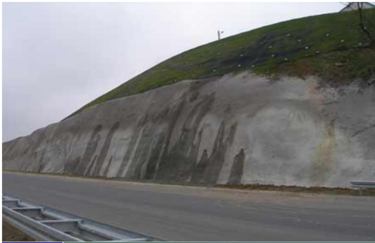
Slika 65. Zaštita pokosa mlaznim betonom
