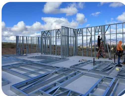
Montaža panela na gradilištu
