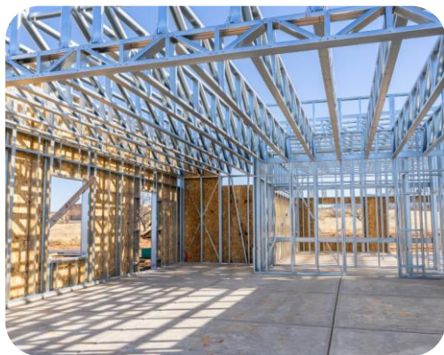
Oblaganje, punjenje izolacijskim materijalom, instalacijama itd.
