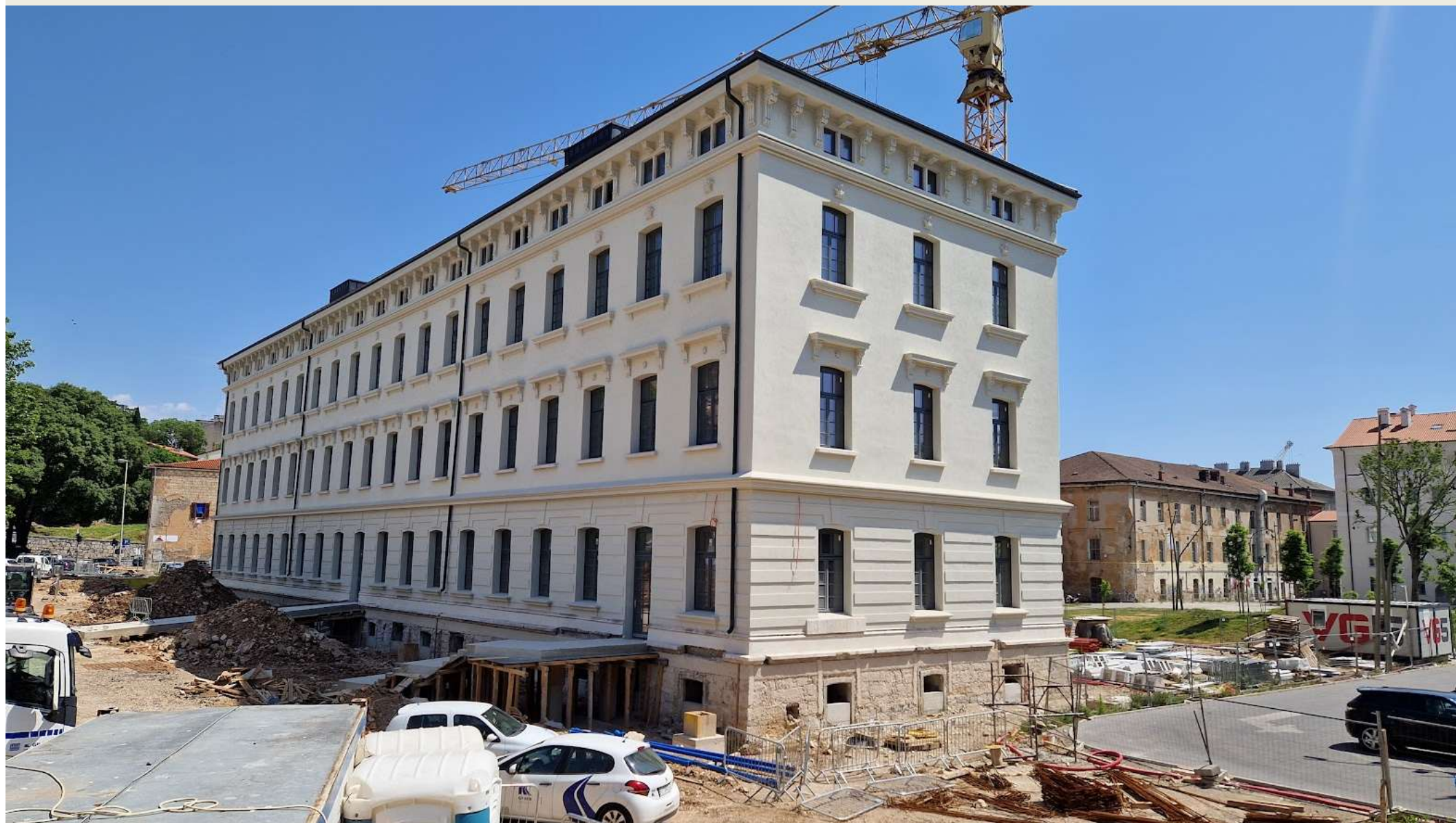
Fasada pri kraju radova i izrada ab mostova za ulaz u objekt sa sjeverne strane.
