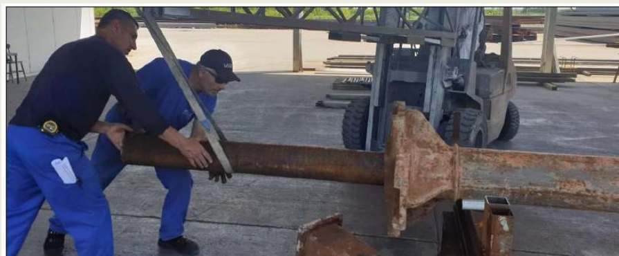
Provlačenje čeličnih stupova kroz željezni stup.
