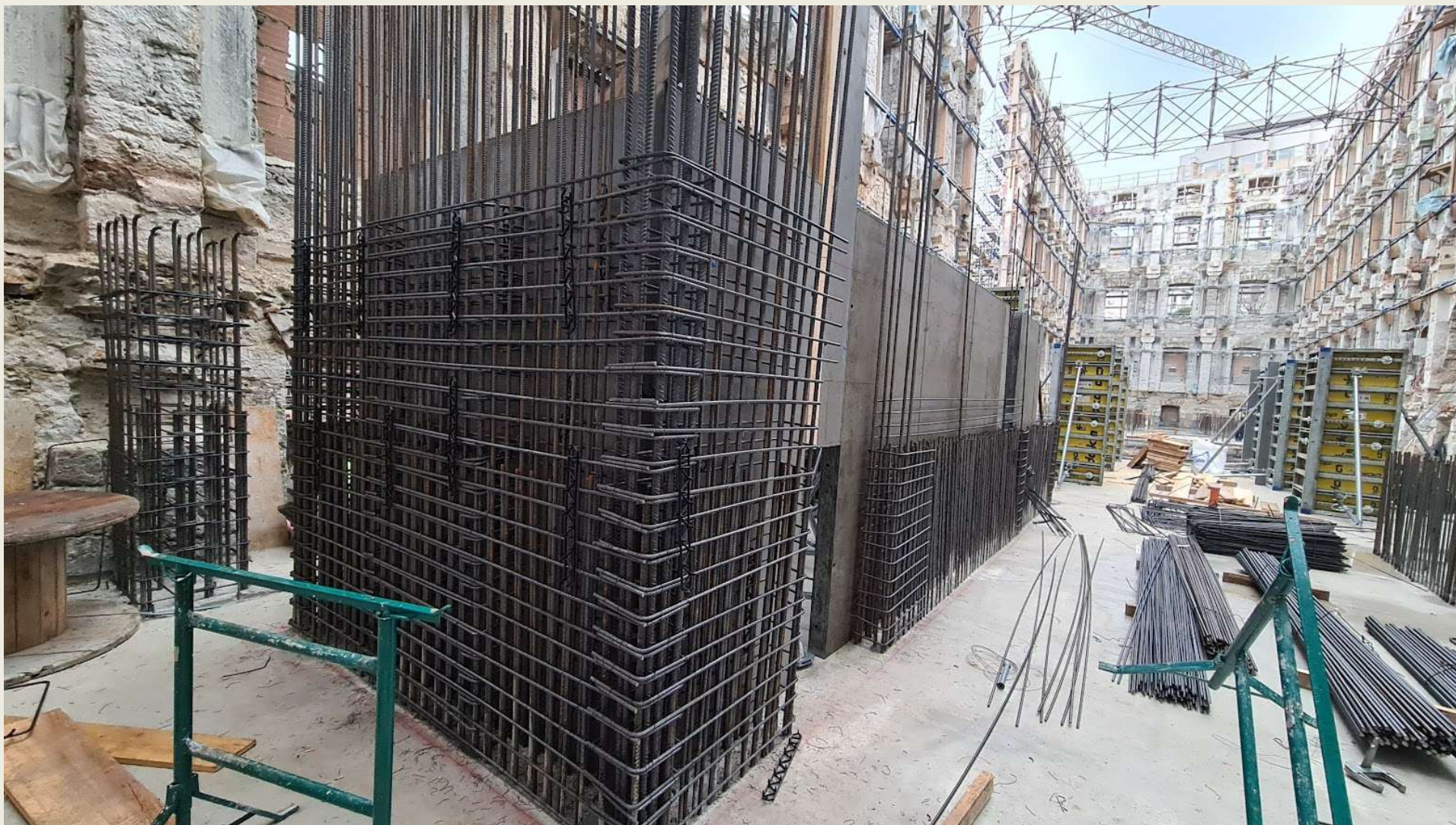
Armirano betonske jezgre – lift i stubišta.
