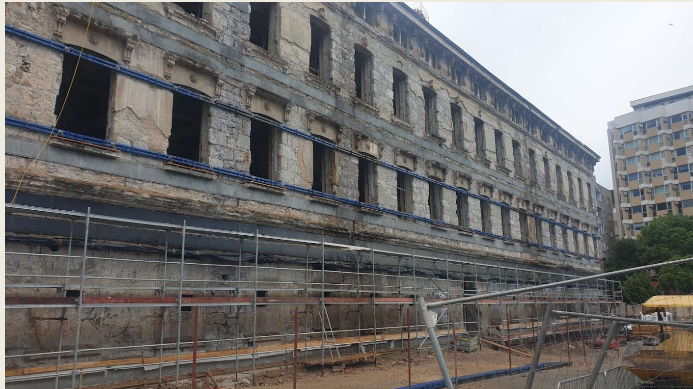
CFRP trake – vertikalno i horizontalno provlačenje.
