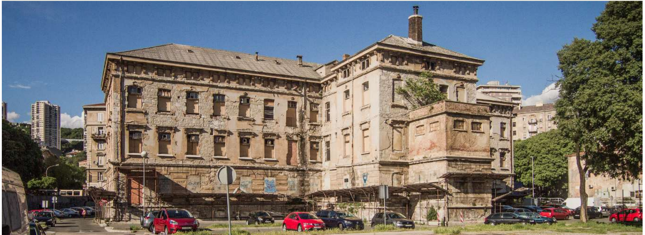
Zatečeno stanje T-zgrade prije početka radova – osnovna zgrada i nožica.
