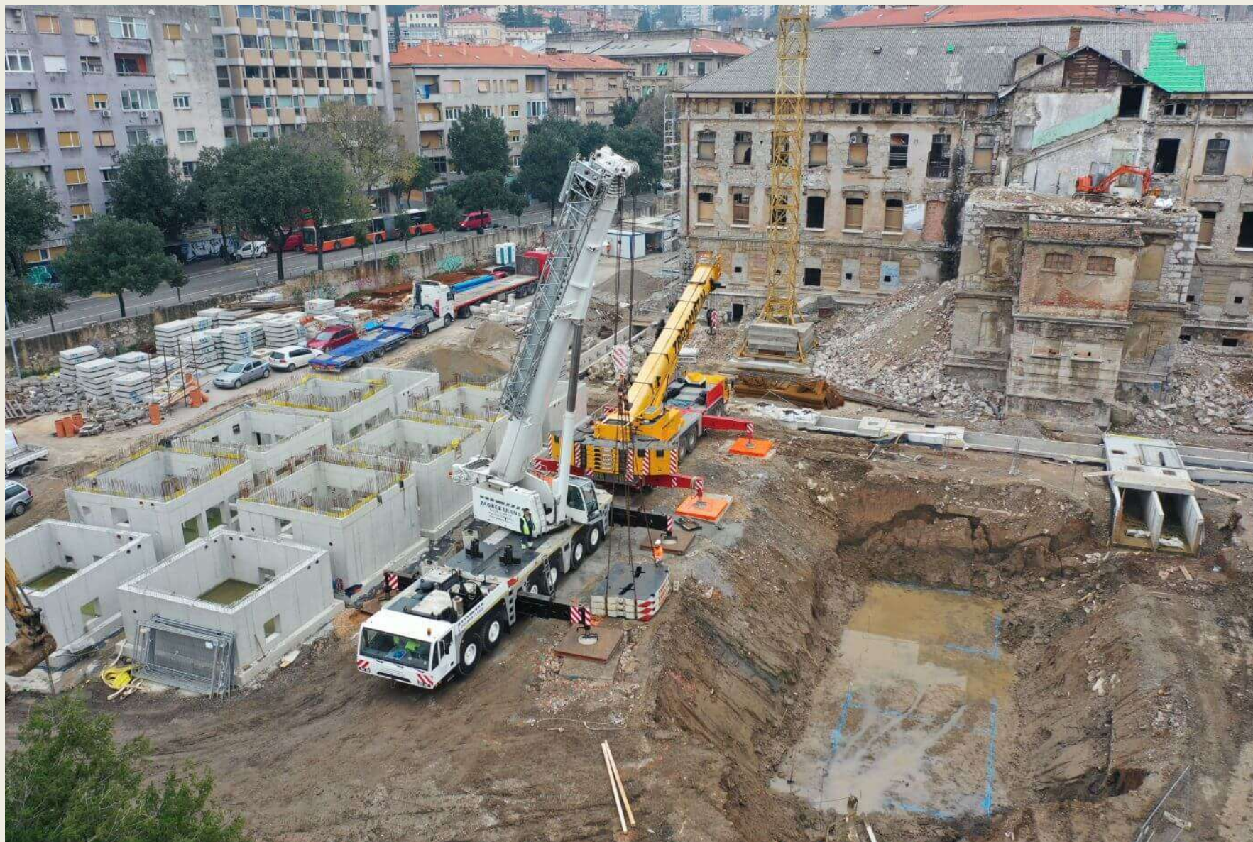
Polaganje bazena i retencija – dvije dizalice u paru, cca. 60 tona po građevini.
