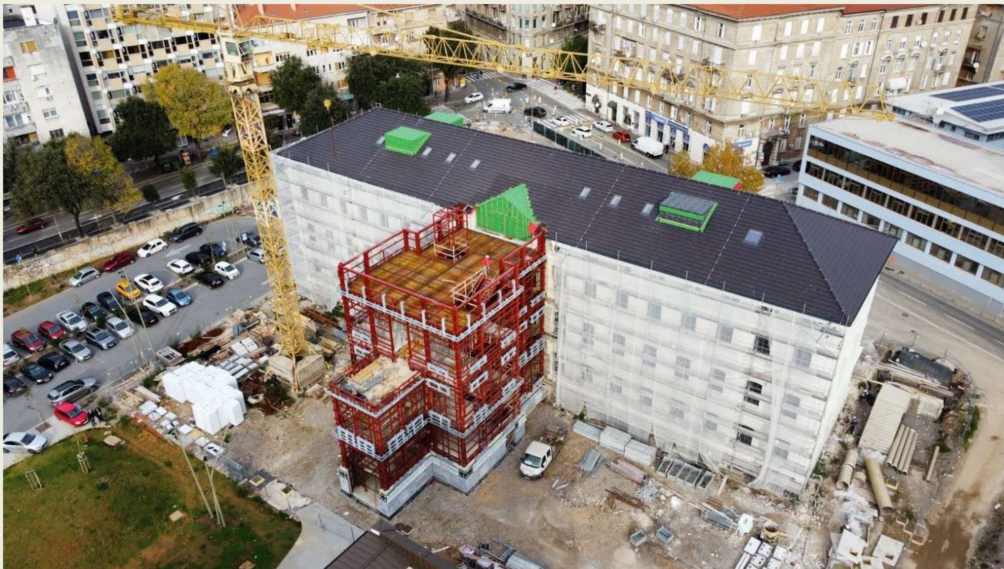
Gotova konstrukcija glavne zgrade i nožice (vidljiva glavna i sekundarna konstrukcija za fasadne elemente).
